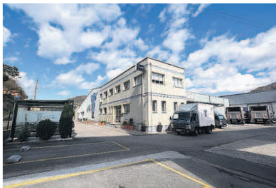
Instalaciones del macelo de Asturias. | LNE
