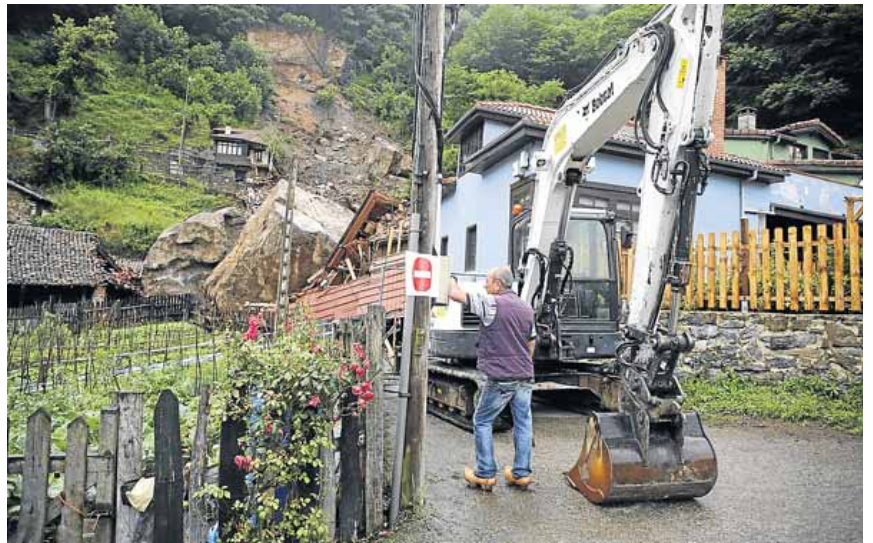
Una máquina, junto al argayo del pueblo lenense, a la espera de iniciar los trabajos. :: JUAN CARLOS ROMÁN
