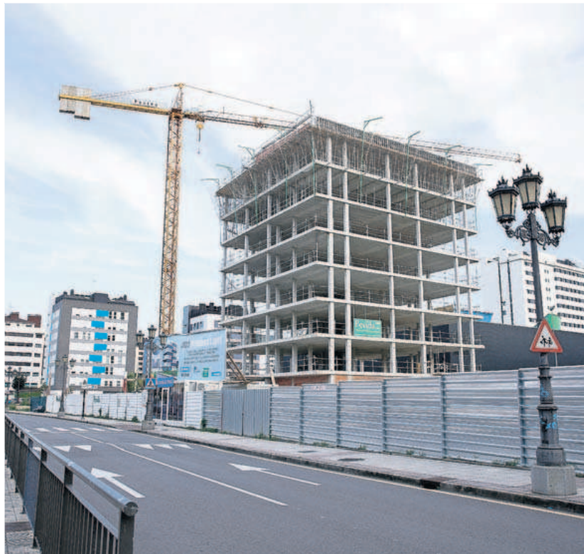
Un edificio en construcción en Prados de la Vega. | CAROLINA DÍAZ
