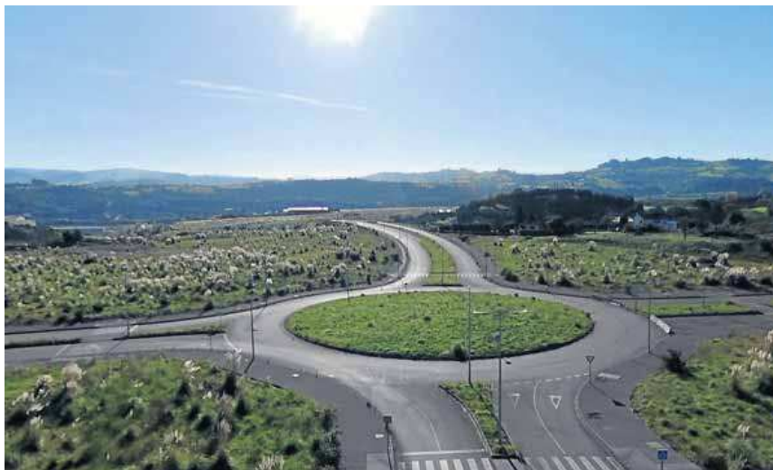
Terrenos de la ZALIA, en la actualidad completamente vacíos. :: E. C.
