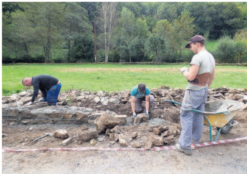
Varios albañiles reconstruyen uno de los muros del pueblo. | D. ÁLVAREZ
