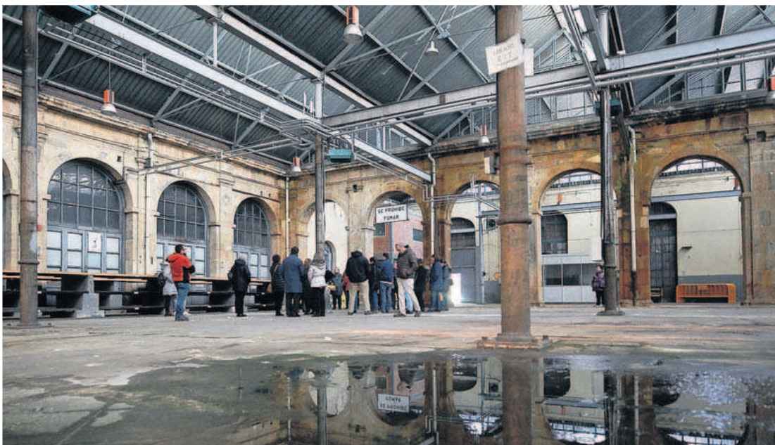
El interior de una de las naves de la antigua fábrica de armas de La Vega. | LUISMA MURIAS
