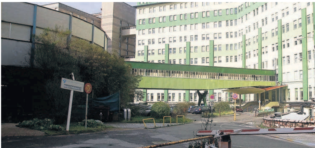
El recinto hospitalario del Cristo, ya abandonado. | LUISMA MURIAS
