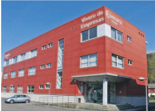
Complejo de oficinas
