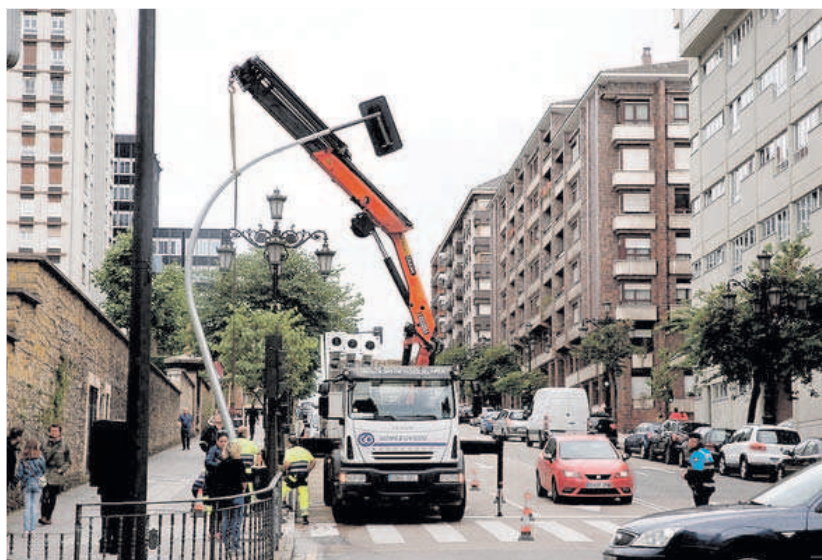
Operarios de Aluvisa, en una imagen de archivo, trabajando con un camión-grúa de los que tienen que alquilar al no disponer del vehículo de estas características que figura en el contrato. | MIKI LÓPEZ
