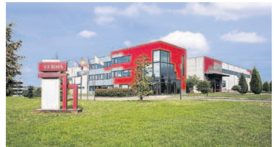
Las instalaciones de Tekox. | FOTO CEDIDA A LNE POR TEKOX
