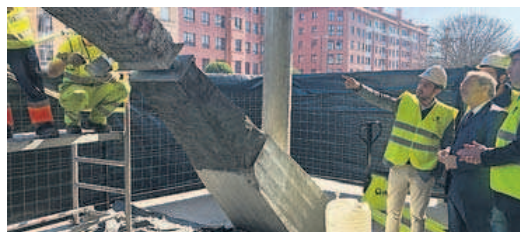
El Alcalde, con responsables de la constructora, durante la visita. | LNE
