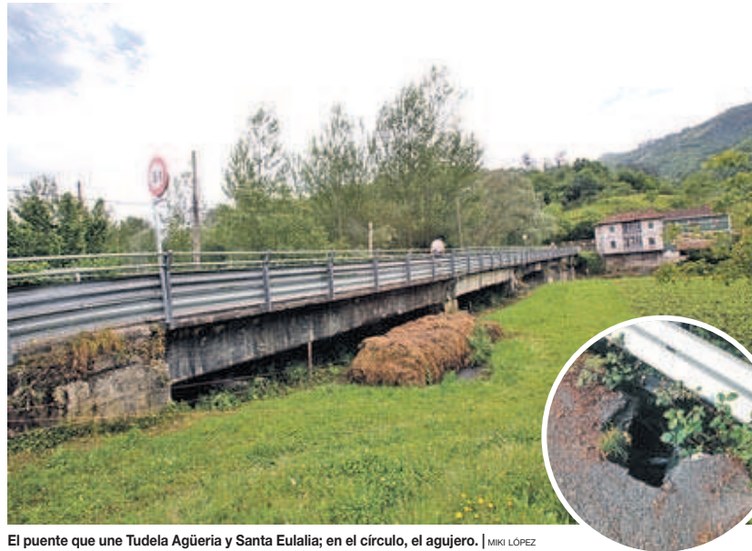
El puente que une Tudela Agüeria y Santa Eulalia; en el círculo, el agujero. | MIKI LÓPEZ
